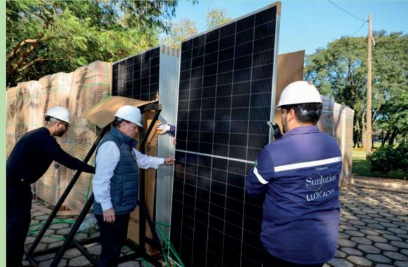
ITAIPU Binacional avanza en la instalación de la **Planta Solar Flotante (PSF)** en el embalse de la Central Hidroeléctrica, con una potencia pico prevista de 1.105,44 kWp (kilovatio pico). Ya llegaron a la entidad tres contenedores con un total de 1.782 paneles solares bifaciales, de los cuales, 214 se destinarán como reserva ante posibles contingencias.
